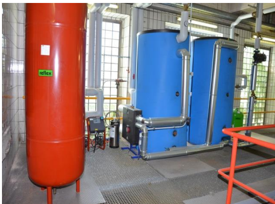
neue Warmwasserbereitung
